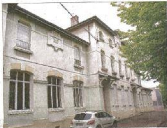
L'école Cuminal avec des travaux d'accessibilité à l'horizon 2019/20, dans l'attente de la finalisation du projet de nouveau groupe scolaire.
